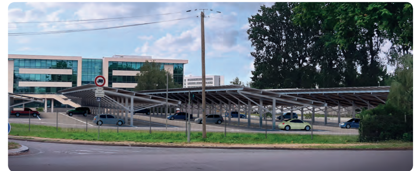
Ombrières photovoltaïques sur le parking d'un immeuble d'exploitation du Campus niortais
